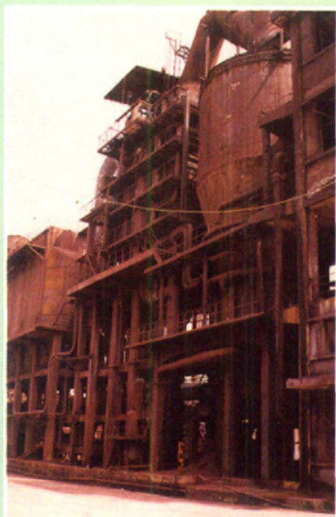
四川硫酸厂年产8万吨硫酸的主 体设备——沸腾炉
