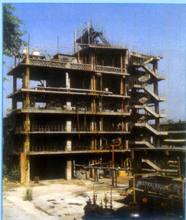
长寿化工厂年产1万吨氯丁橡胶 装置聚合工段
