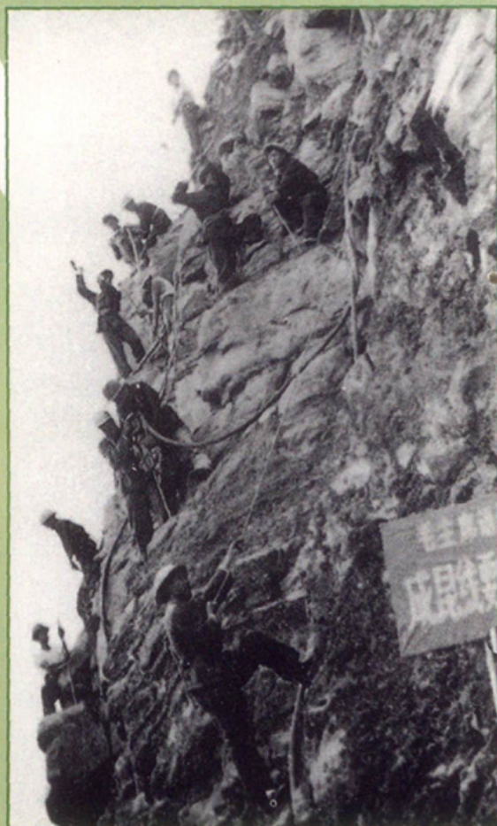
成昆铁路峭壁施工
