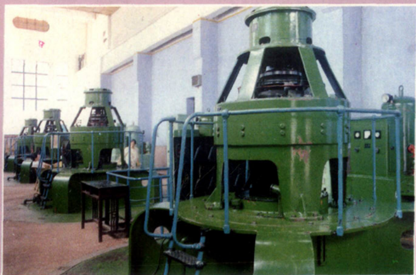
▲1959年，重庆水轮机厂设计制造长 寿大洪河水电站4台单机容量8750千瓦 混流式水轮发电机组
