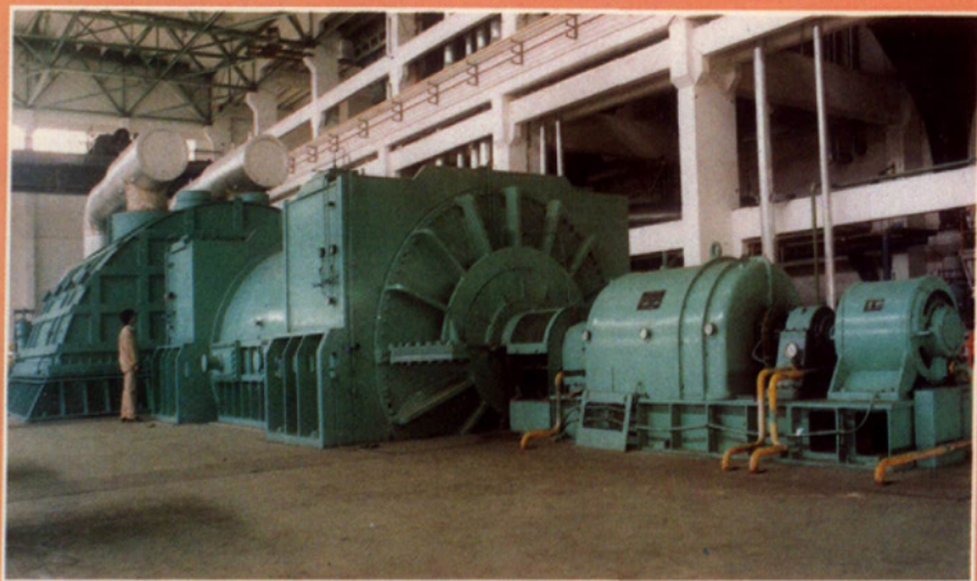
▲1985年，东方电机厂生产的 第一台东方型水氢氢30万千瓦汽轮 发电机在黄台电厂运行
