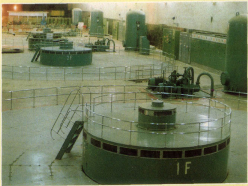
1984年，东方电机厂生产的当时国内最大的混流式33万千瓦水轮发电机组在龙羊峡电站运行
